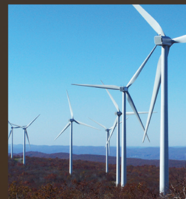
BEAR CREEK Luzerne, PA 24 MW
