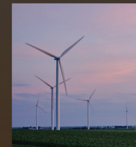
CRESCENT RIDGE Bureau Co., IL 54.5 MW
